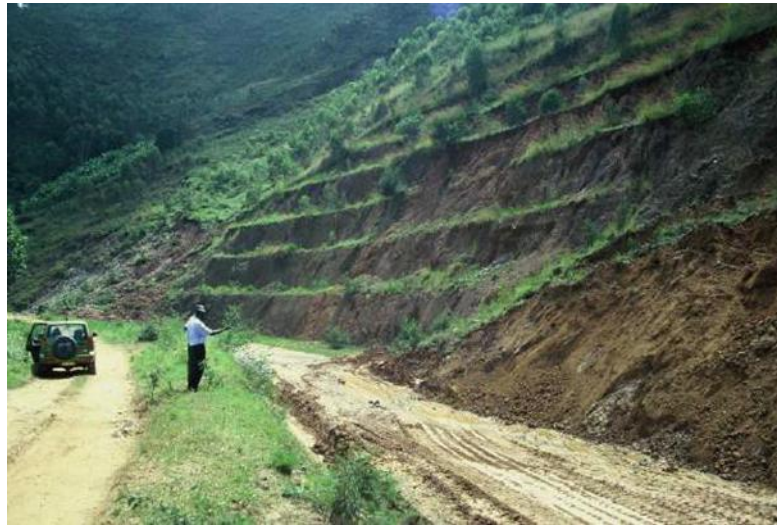
Figure 15 Fermeture d'une route pour cause de rupture de pente. Notez la déviation à gauche créée pour contourner la rupture
