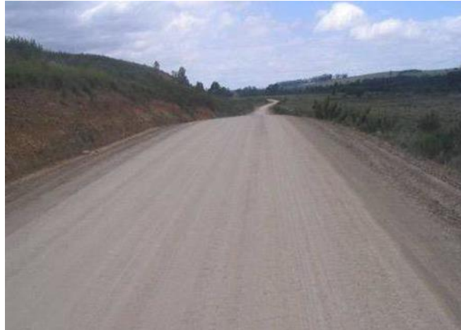
Figure 7 Route en terre battue typique montrant la structure façonnée et la couche de roulement en gravier
