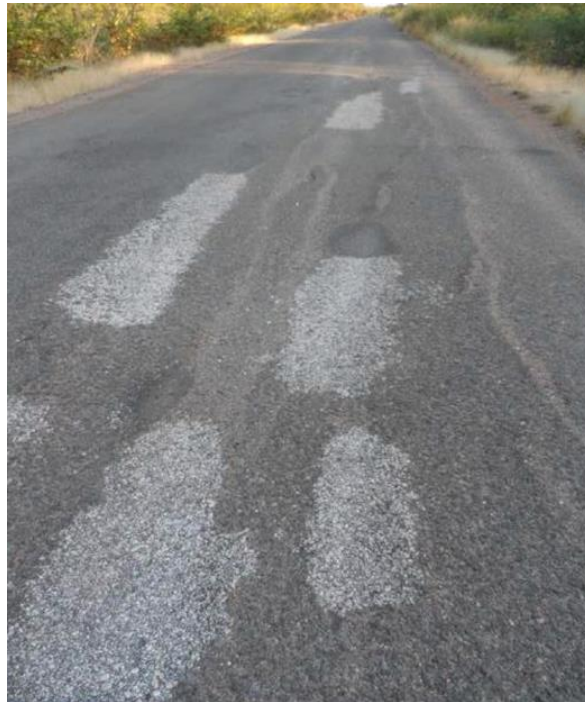
Figure 29 Exemple de détresse récurrente dans un remblai en raison de l'utilisation de sols hautement dispersifs comme matériau de remblai
