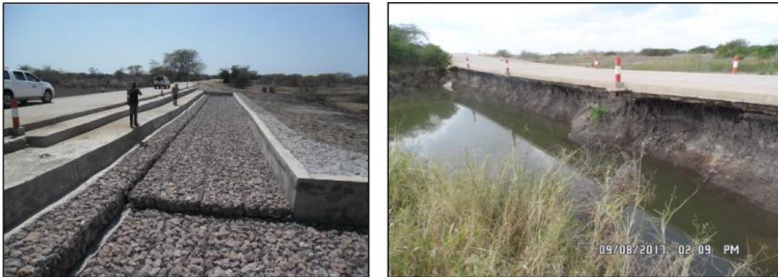
Figure 9 Exemple de mesure d'adaptation pour protéger une tranchée/gué contre les dommages causés par les inondations
