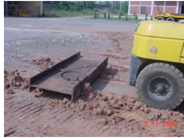
Hình 48 - Tẩy sóng mặt đường cấp phối hoặc mặt đường đất: dùng thanh sắt chữ I
