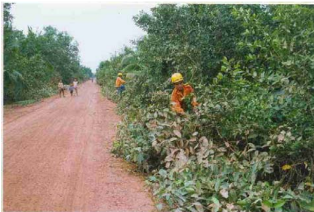
Hình 13 - Nhà thầu bảo dưỡng đường GTNT
