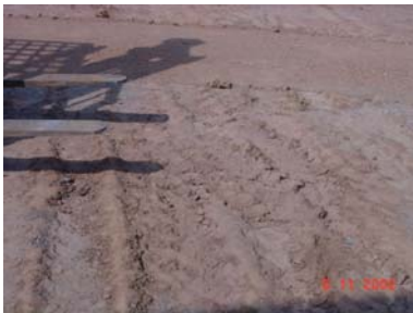
Hình 49 - Mặt đường thực nghiệm ở Việt Nam, trước và sau khi san bằng thanh thép I
