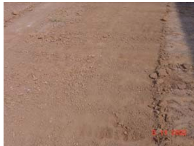
Hình 49 - Mặt đường thực nghiệm ở Việt Nam, trước và sau khi san bằng thanh thép I
