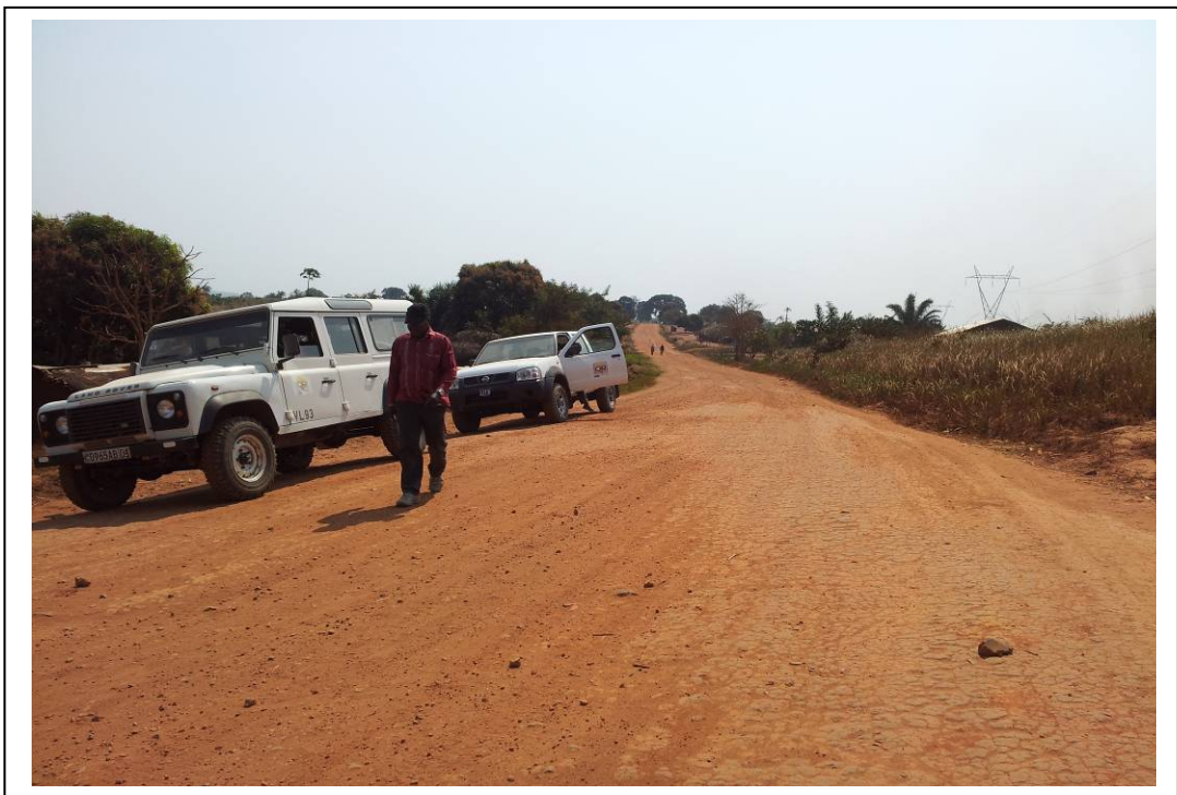
Route Kalemie-Uvira, tronçon 1 : Sol limoneux plastique et poussiéreux, glissant pendant la saison des pluies
