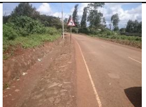
Figure 2-3: Bon - Revêtement de drainage relié au bord du revêtement
