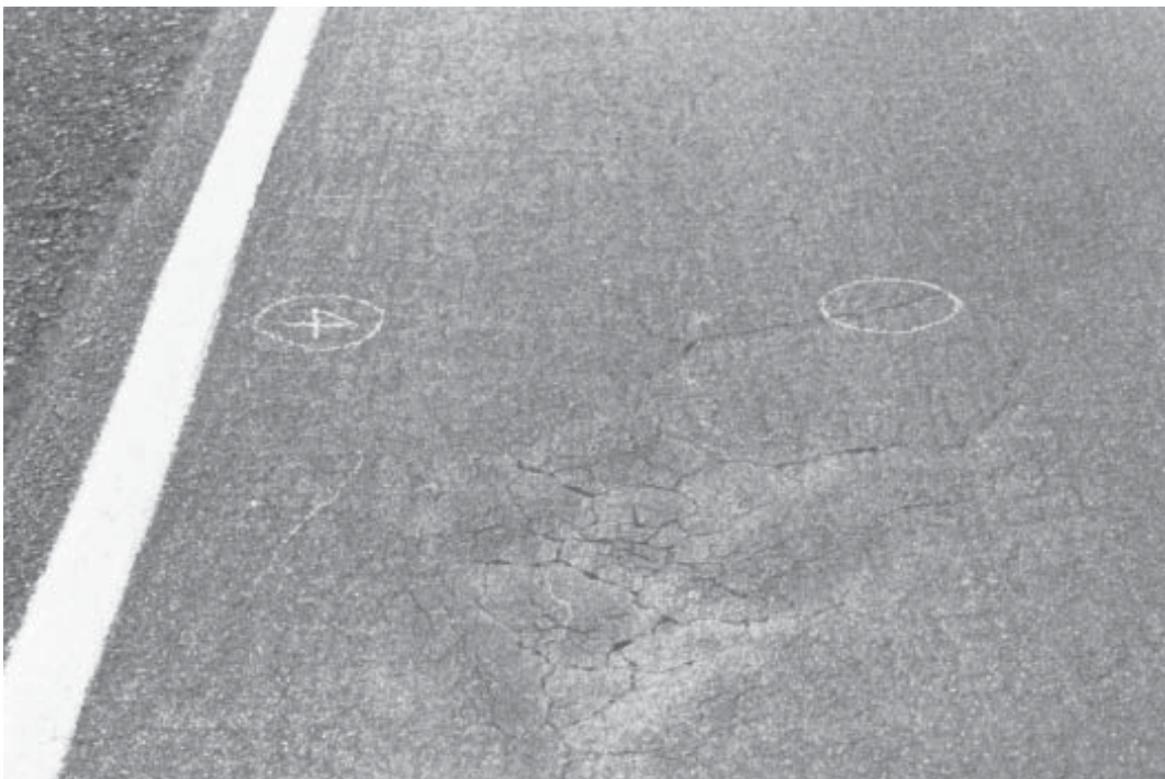
ស្ពានប្រេះ និង ស្ពានបែកដោយសារកង្កែបក្នុងក្រាលលើផ្លូវក្រាល
